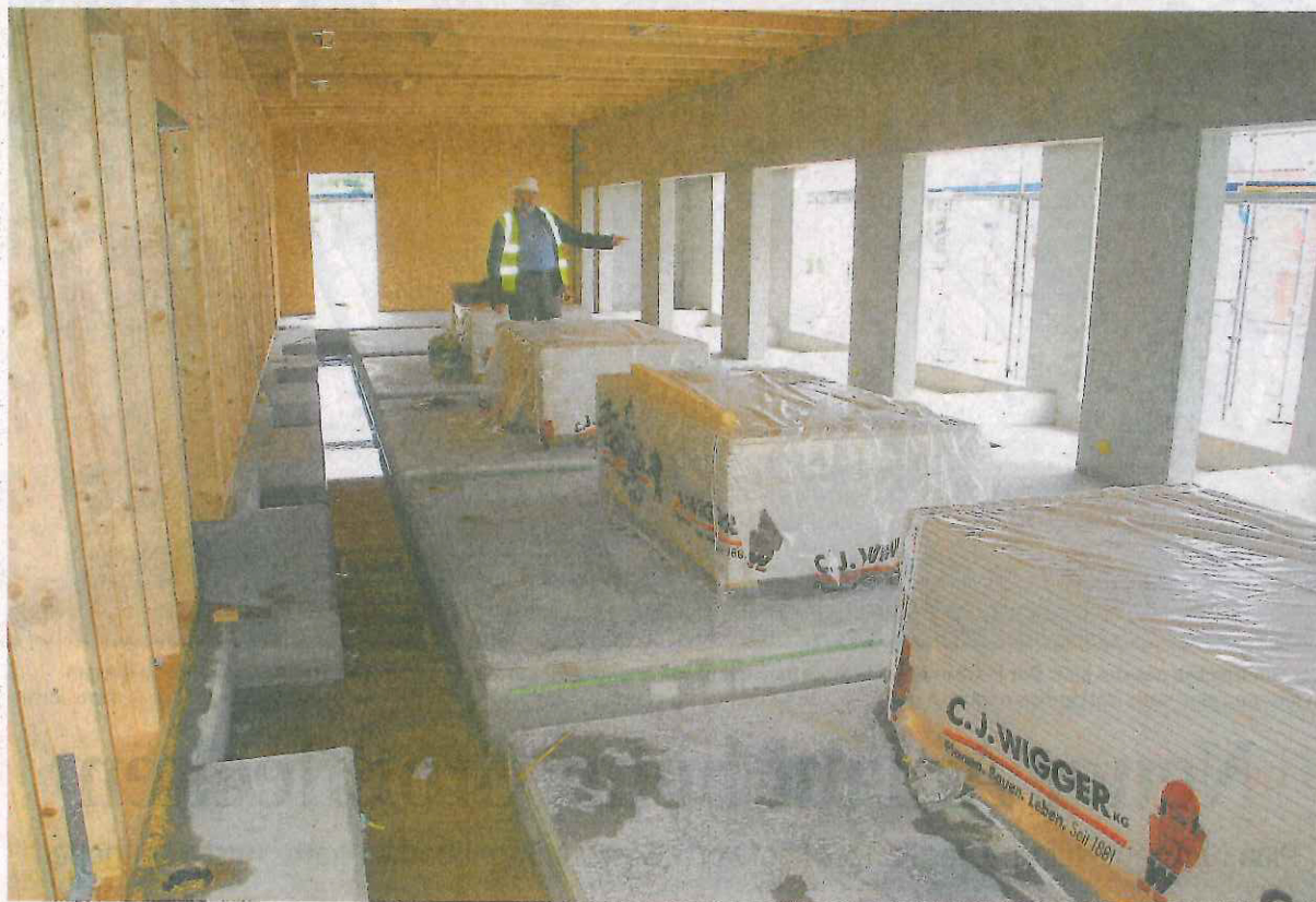
VBB-Geschäftsführer Frank Günther zeigt die Kammern für die Trafos im Rohbau des Batteriespeichers.
