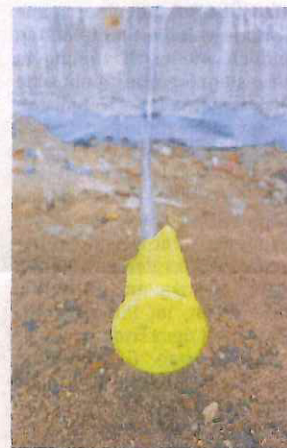
20 Erdungsfestpunkte sollen den Batteriespeicher vor Schäden absichern.
