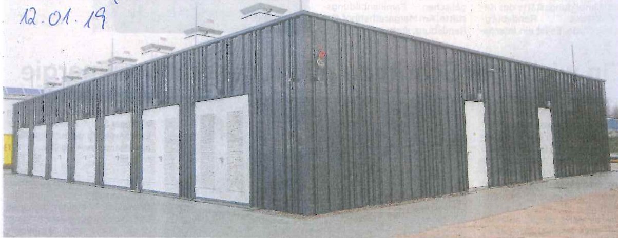
Auf dem Gelände der Versorgungsbetriebe Bordesholm (VBB) entsteht, begleitet von einem Forschungsvorhaben der TH Köln, aktuell eines der modernsten Regelenergiekraftwerke der Welt. FOTOS: JAN KÖSTER
